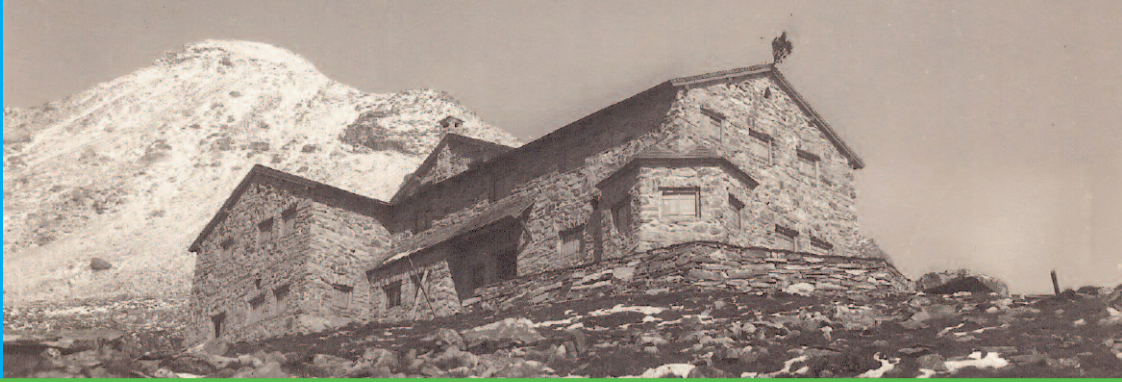
Das Friesenberghaus im Bau. Foto von Wilhelm Durand, 1929. Madeleine Durand-Noll, Cochem
